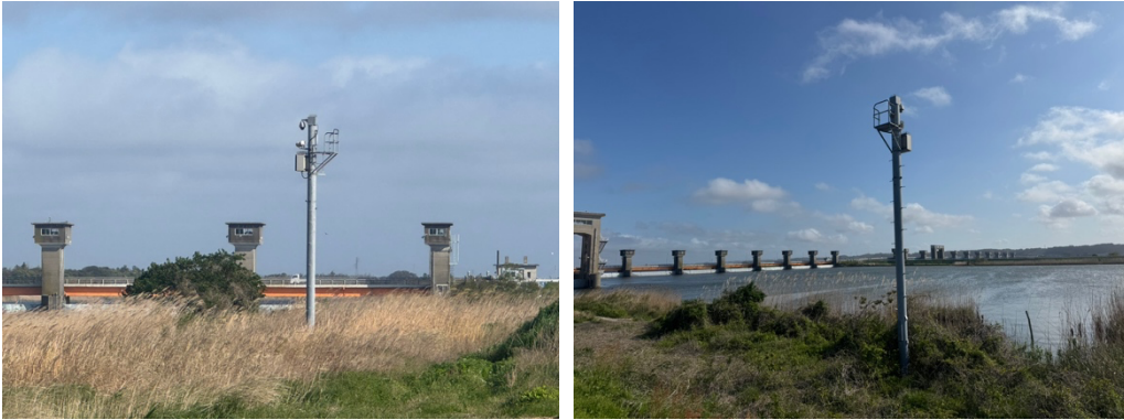
写真左：上流から水門に向かって右岸の目印。写真右：上流から水門に向かって左岸の目印
